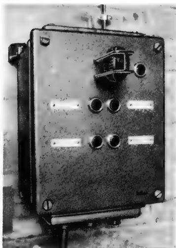
Bild 4. Eine Wechselsprechstation im Hüttenwerk, die sich auf die drahtlose Kran-Sprechanlage aufschalten läßt
