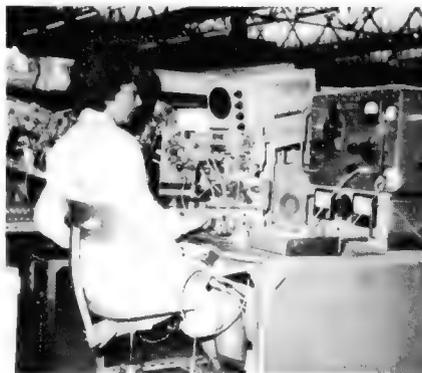
Oben: Bild 2. Fernseh-Zf-Abgleich und -Prüfung
