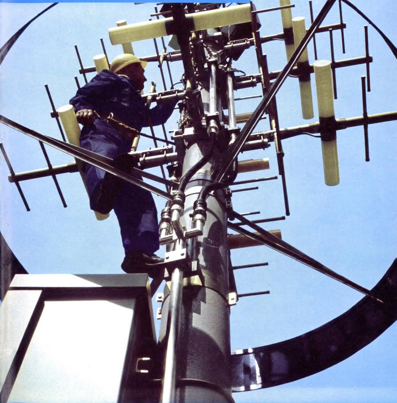
Am Fuba-Antennenmast werden drei Ebenen einer aus sechs Ebenen bestehenden Sendeantenne für einen 5-kW-Fernsehsender montiert (siehe unsere Titelgeschichte Seite 410)
